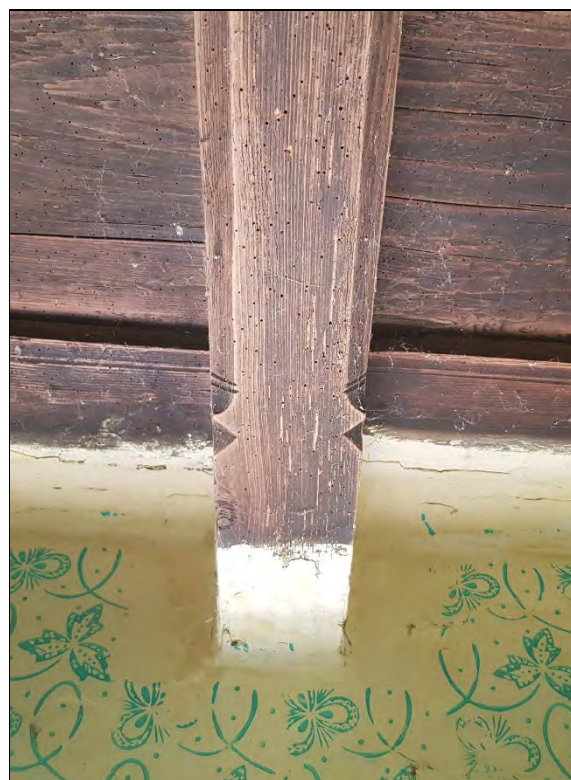
43. – 44. kép. Pórfödém és gerendája a pitvarban (előtérben)
