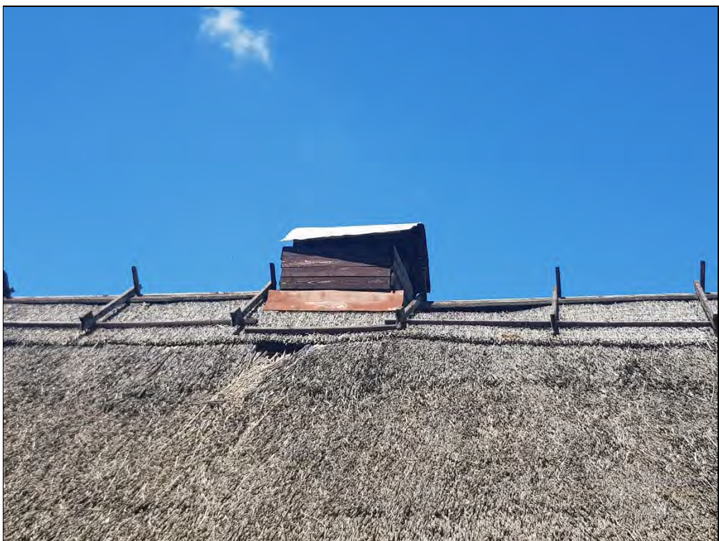
89. kép. A szabadkémény kürtő kialakítása
