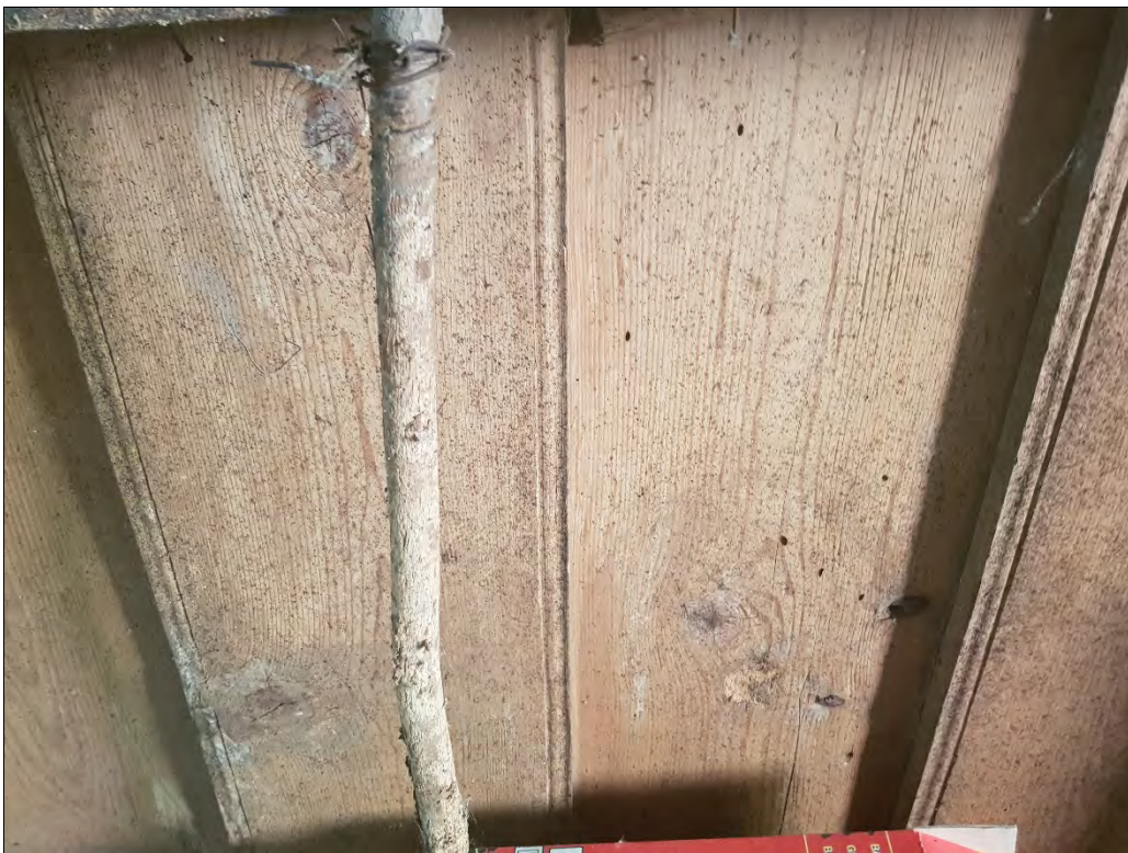
79. kép. Pórfödém a tároló helyiségben
