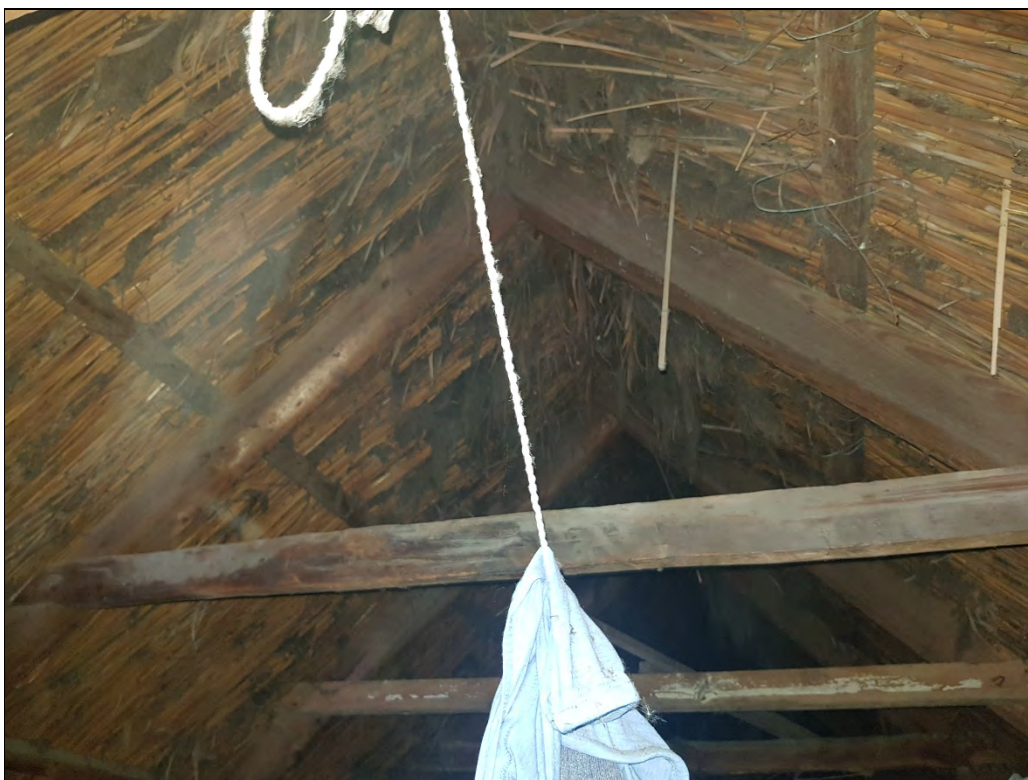
84. kép. A tetőszerkezet 2.
