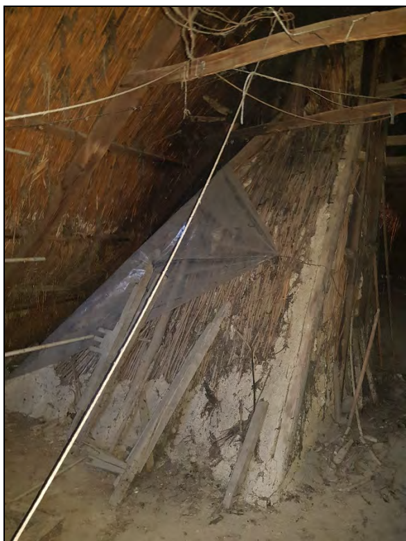
86. – 87. kép. A szabadkémény kürtője a padlástérben: déli és északi oldal
