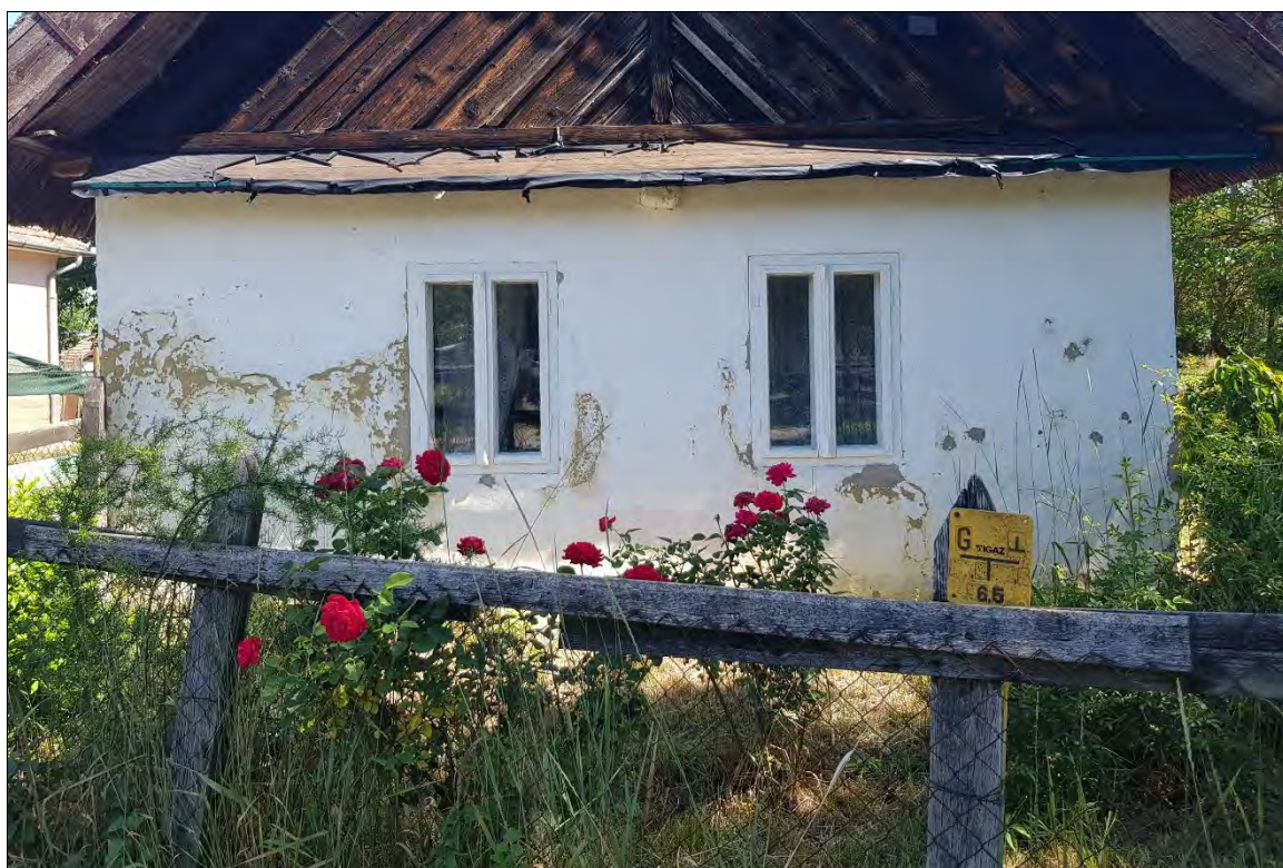
16. kép. A déli homlokzat ablakai
