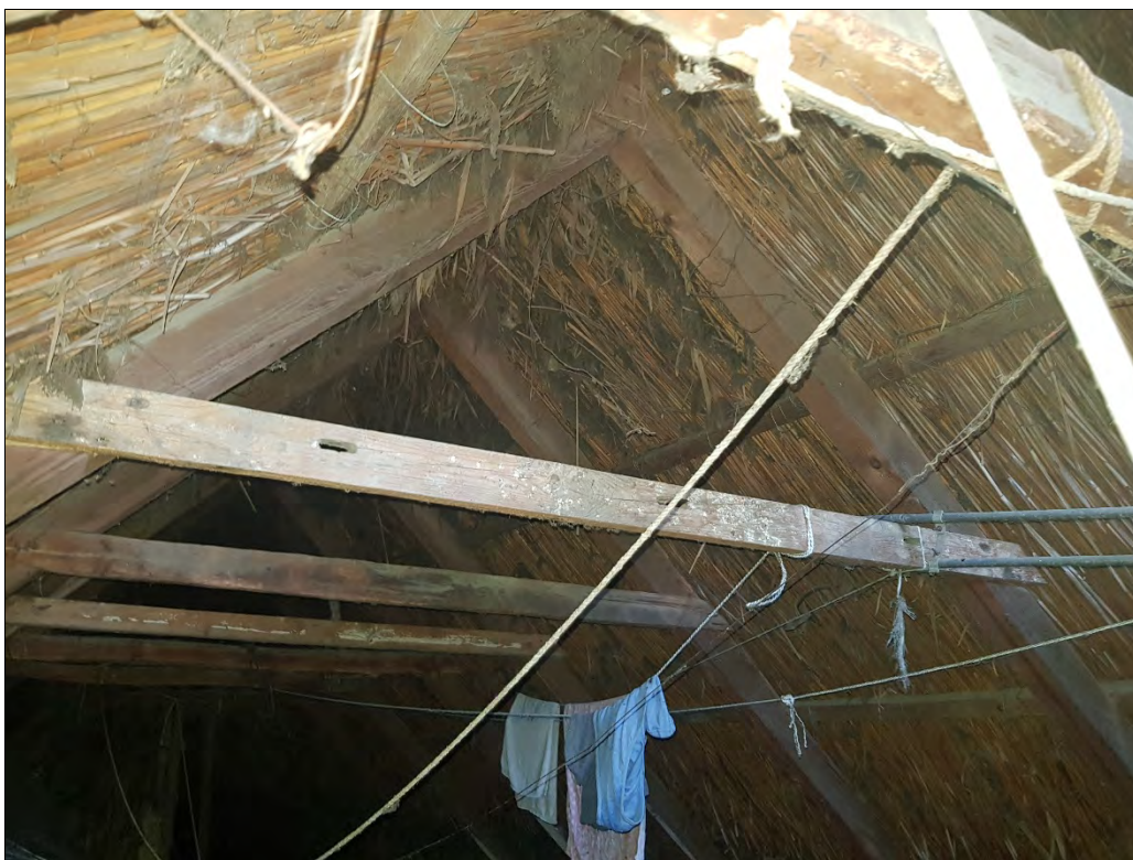
83. kép. A tetőszerkezet 1.
