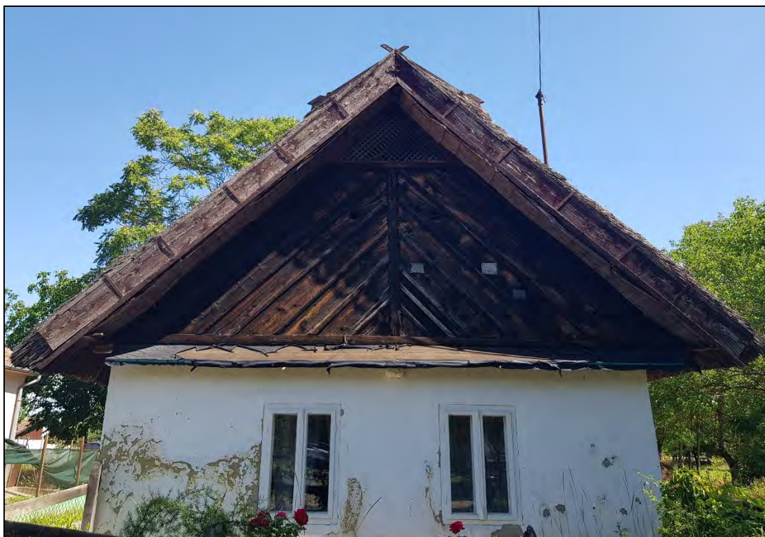
13. kép. A deszkaoromzat a déli homlokzaton
