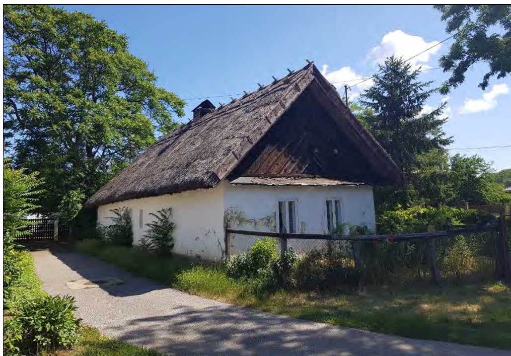
2. kép. A népi lakóépület délnyugat felől
