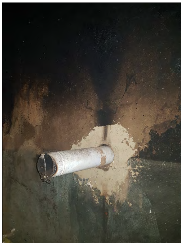
54. kép. Füstelvezető átvezetés a konyha északi oldalán
