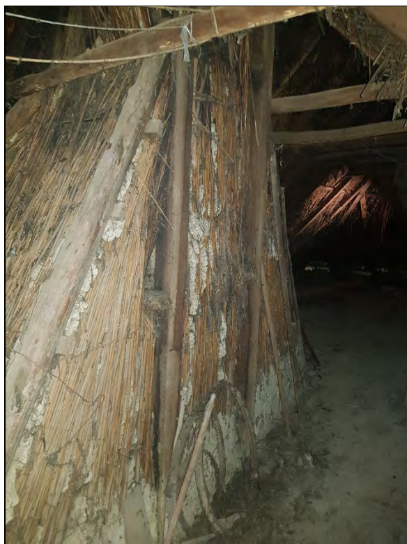
88. kép. A szabadkémény kürtője a padlástérben: keleti oldal
