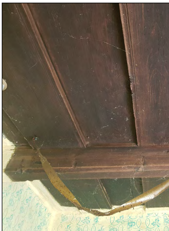
43. – 44. kép. Pórfödém és gerendája a pitvarban (előtérben)
