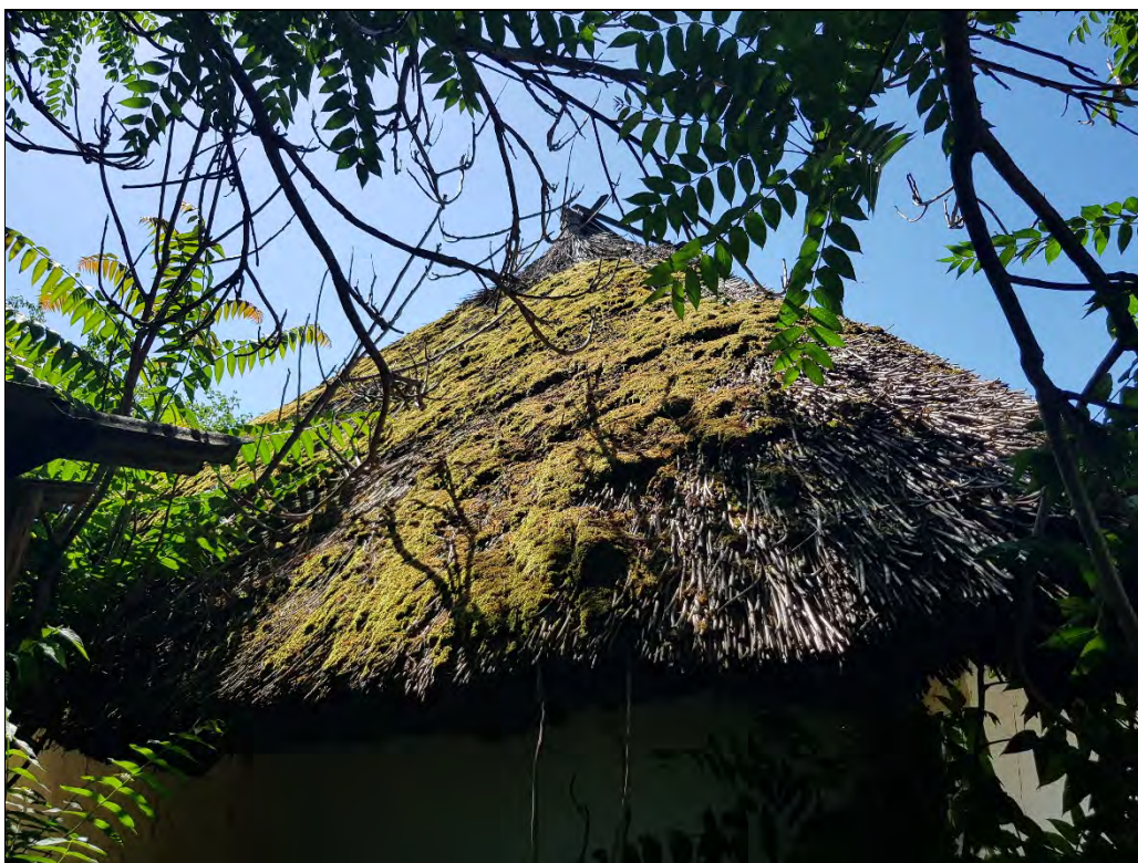
36. kép. Az északi kontyolt tetősík
