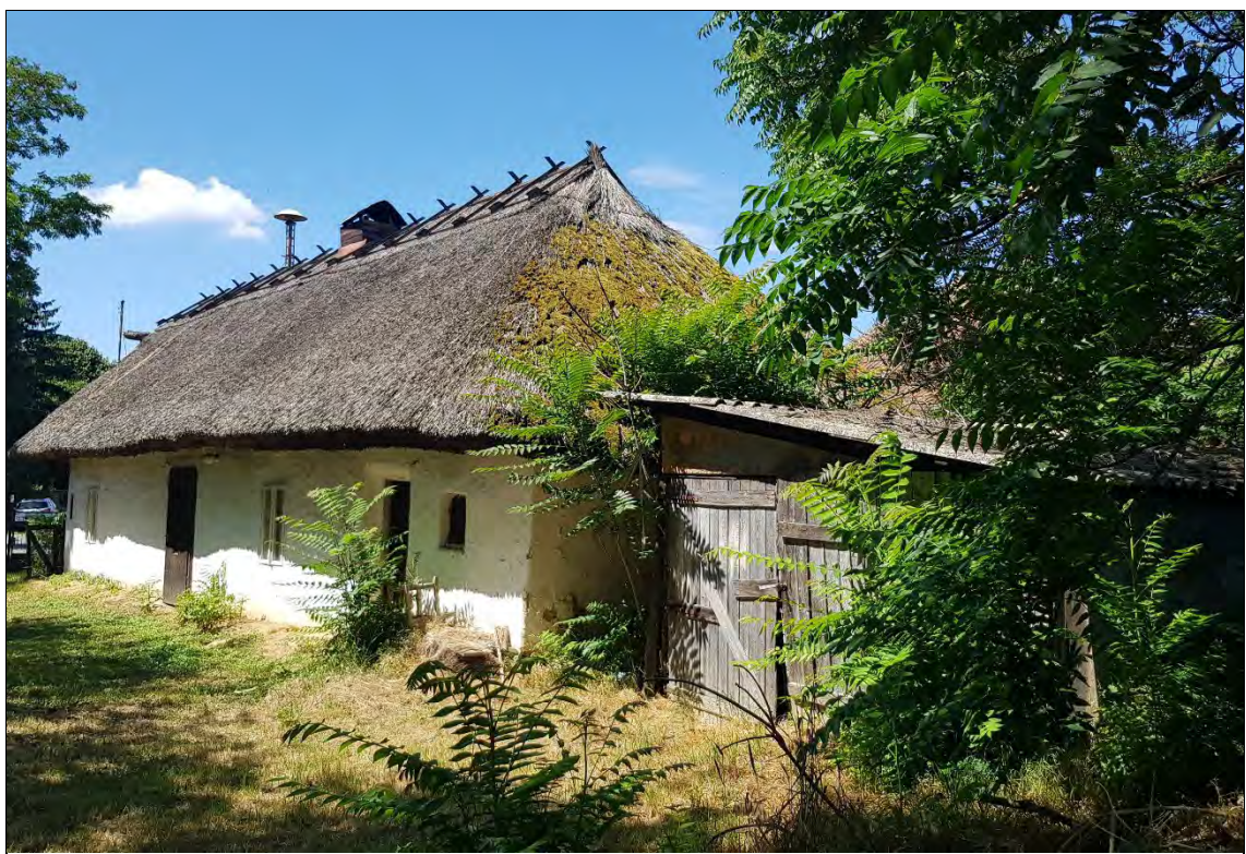
21. kép. Az épület képe és udvari homlokzata a gépjárműtárolóval északkeletről
