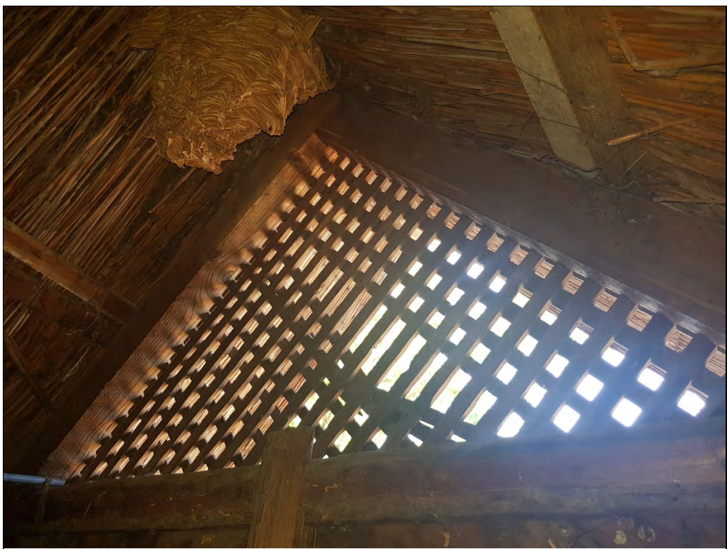
90. kép. Az apácarácsos csúcsdíz a deszkaoromzaton
