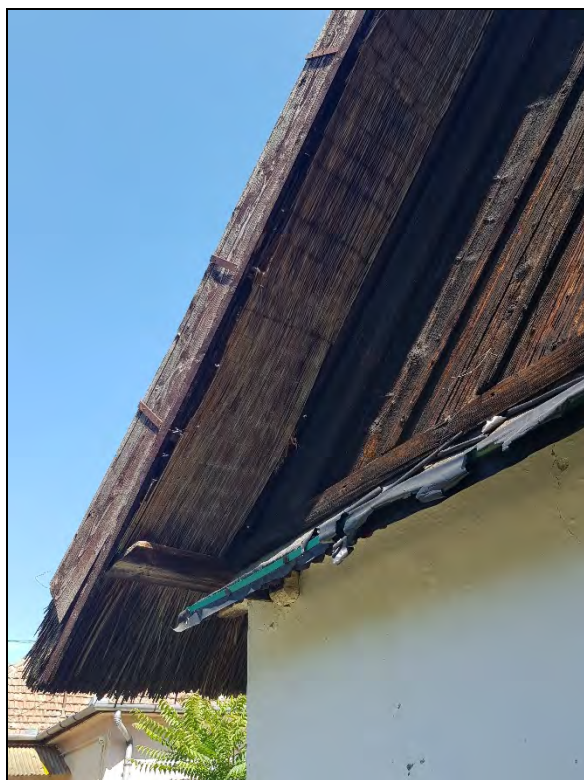
15. kép. A déli oromfalas homlokzat, a vízvető és a héjazat csatlakozása
