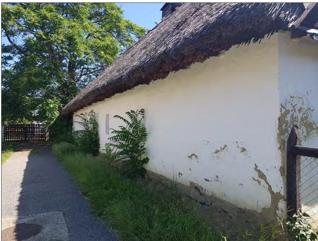
37. kép. A lakóépület nyugati homlokzata
